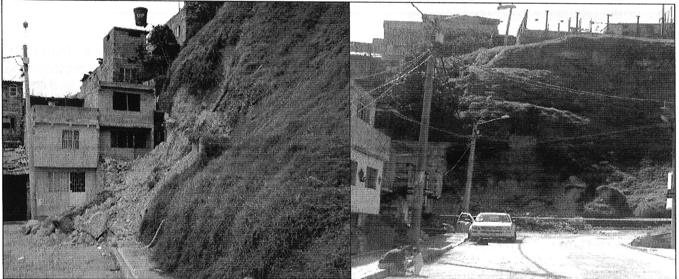
Fotografía 2 y 3. Detalle del desprendimiento de suelo y roca desde la parte media del talud, ocasionando el rompimiento de la malla eslabonada y la caída parcial del mortero de recubrimiento.
