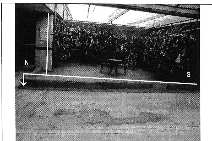
Fotografía 9. Desnivel primer nivel, con pendiente aproximada del 3% de este sector del costado sur, edificio Pijao Calle 149 # 48 - 31.
