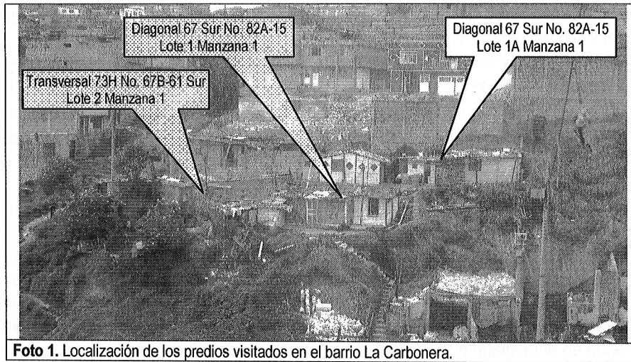
Foto 1. Localización de los predios visitados en el barrio La Carbonera.
