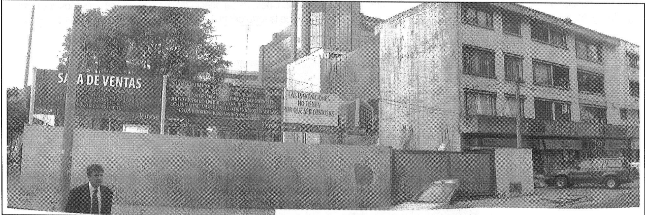
Foto 5. Localización relativa del proyecto urbanístico Varese (Av. Carrera 19 No. 97-50) con respecto al emplazamiento del edificio de la Transversal 18A No. 97-29.
