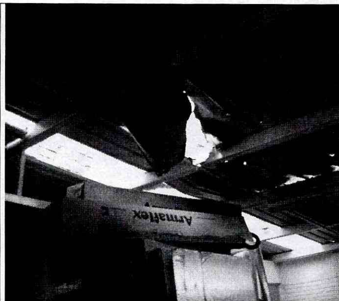
Fotografía 3. Hueco de aproximadamente 1 m de largo por 0.80 m de ancho en la teja termo-acústica de la parte posterior del predio de la Avenida Carrera 9 # 123 – 66, provocado por el material que cayó desde el predio vecino.
