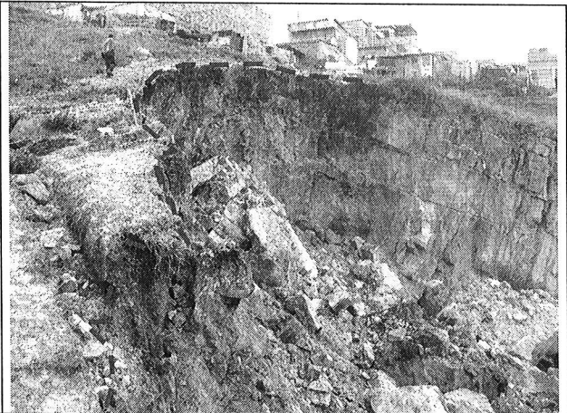
Foto 2. Sector suroriental del talud de corte en el que se presentó el avance del proceso.
