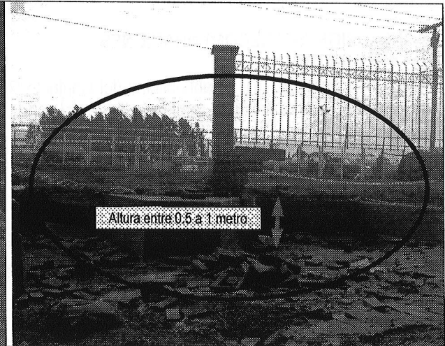
Foto 4. Se observa el muro en concreto con una altura cercana entre 0.5 a 1 metro, el cual no presenta deformaciones ni fisuras al momento de la inspección.
