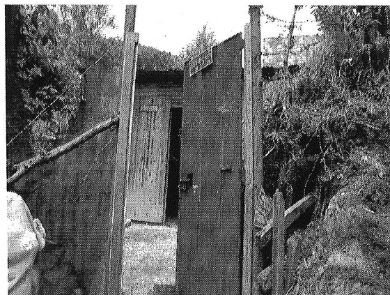
Fotografía 1. Vista general del predio de la referencia. Hacia el costado sur del mismo (derecha de la foto) se encuentra un talud de corte afectado por desprendimiento de materiales.
