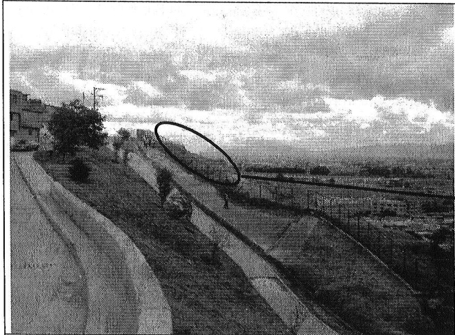
Foto 15 y 16. Costado occidental del antiguo frente de explotación de materiales. En la corona de los taludes de corte se observan grietas de tendencia dispersa con abertura de hasta dos centímetros, a través de las cuales se podría infiltrar aguas lluvias y/o de escorrentía superficial que podría saturar los taludes de corte y/o detonar su falla.
