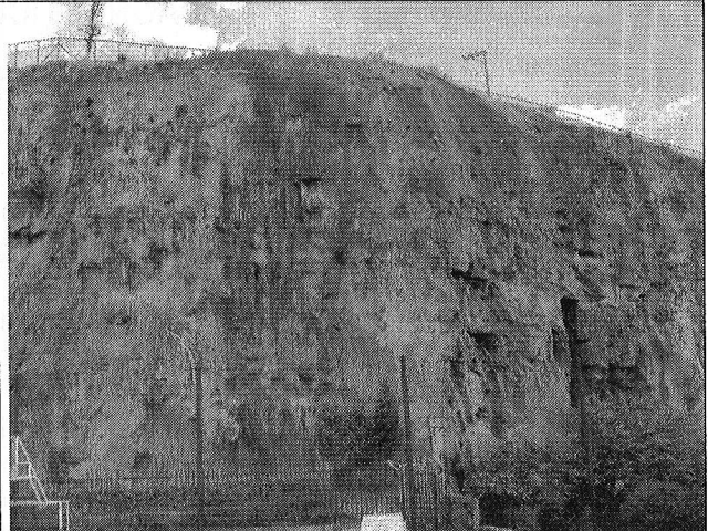
Foto 4. Sector ubicado entre el costado norte y la zona centro del antiguo frente de explotación de materiales evaluado. En este sector no se encontró evidencia de desprendimientos de la cobertura en concreto que reviste los taludes de corte, ni del desprendimiento de rocas, suelo y/o detritos.
