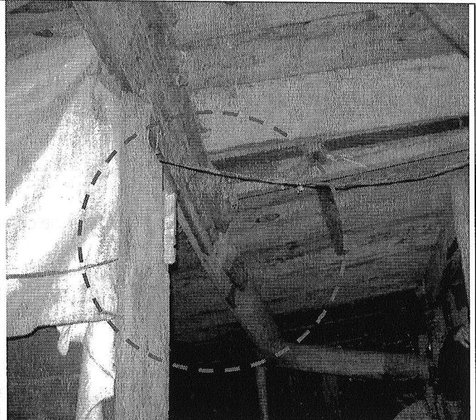
Fotografía 5 y 6. Elementos de apuntalamiento artesanal de la estructura en madera que conforma el entrespacio del nivel superior de la vivienda. Se que los elementos horizontales se han pandeado comprometiendo la estabilidad de la vivienda. Mayo 14 de 2009.
