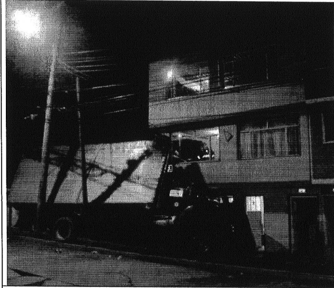
Fotografía 1. Colisión de un camión furgón 600 identificado con las placas SYA-147, contra la edificación emplazada en el predio de la Av. Carrera 104 # 77 B - 23.
