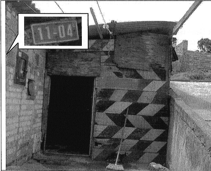
Fotografía 1. Fachada de la vivienda emplazada en la Calle 64 Sur No. 11B -04 Este del Barrio Valparaíso de la localidad de San Cristóbal, la cual corresponde a una vivienda de dos niveles construida en material de recuperación. Mayo 7 de 2009.
