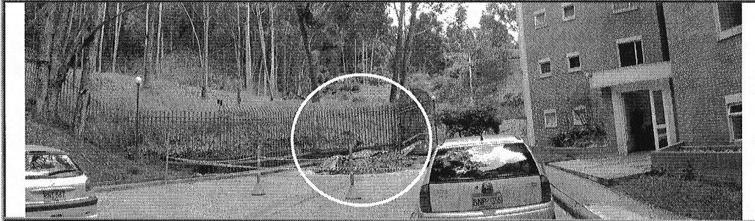
Foto 8. Desprendimiento de material proveniente del sector central de un talud de corte ubicado al costado oriental del predio ubicado en la Carrera 1B No. 54-45
