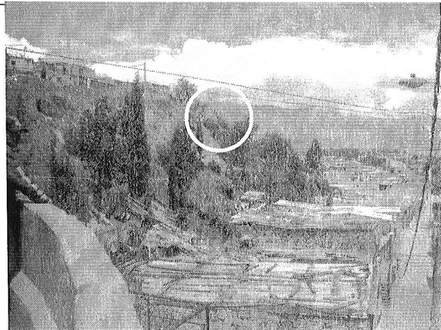
Fotografía 1. Vista general del Tramo Oriental del talud evaluado. Al fondo se observa el sector afectado por flujo de lodos el día 25-Feb-09.
