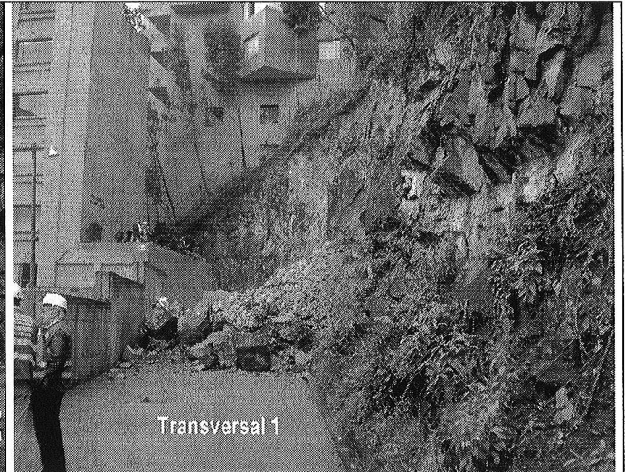
Foto 2. Se observa el material desprendido del talud de corte, el cual se depositó en la parte baja del mismo generando la obstrucción total de la Transversal 1 a la altura de la Calle 84A.
