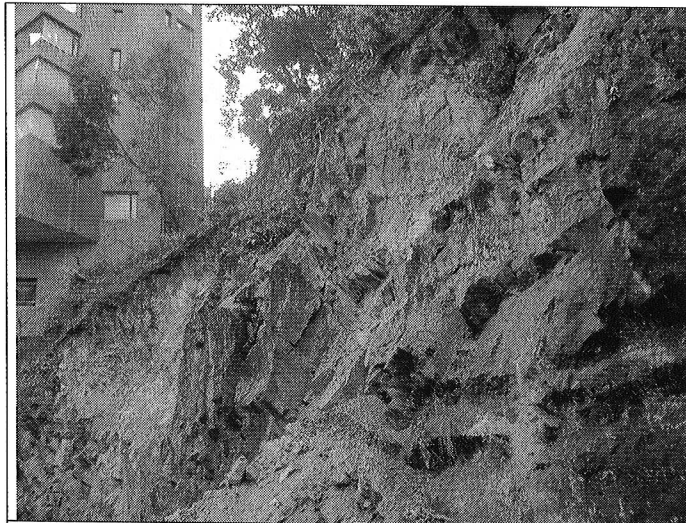
Foto 3. Se observa el estado del talud de corte tras el proceso de remoción en masa. En el sector evaluado los desprendimientos de material permiten apreciar la gran concentración de discontinuidades presentes en el macizo rocoso.
