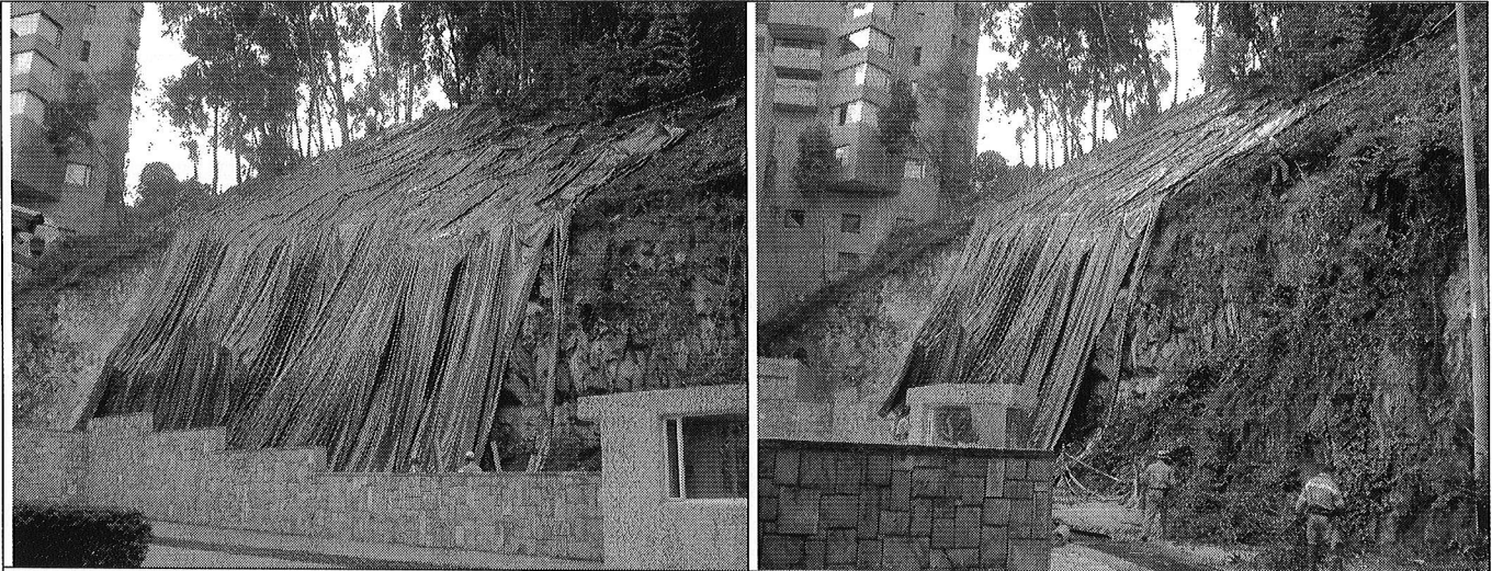
Foto 9 y 10. Se observan las labores de recubrimiento con plástico del talud de corte. Acción implementada con el objetivo de mitigar la filtración de agua en el cuerpo, la corona y la parte alta del talud de corte evaluado. Se resalta que la acción en mención es desarrollada de manera temporal y/o de emergencia y no representa una medida adecuada para garantizar la estabilidad del talud de corte en el mediano y/o largo plazo.
