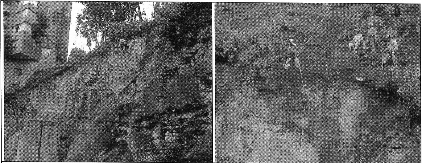
Foto 5 y 6. Se observa el personal de la Defensa Civil adelantando labores de remoción manual de bloques de roca y suelo potencialmente inestable en la parte alta del talud de corte evaluado. Acciones adelantadas como medida de mitigación temporal y/o de emergencia.
