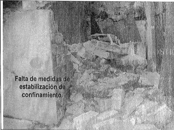
Foto C-1. Vista de del muro de confinamiento del talud de corte el cual se presenta Colapsado, localizado en el costado norte del predio de la Carrera 1B Bis Este # 71-04 Sur (Manzana 93 Lote 5), Barrio San Juan de Usme de la Localidad de Usme.
