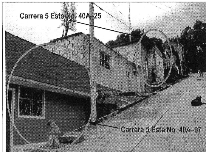
Foto 1. Vista general de las viviendas emplazadas en la Carrera 5 Este No. 40A-25 y Carrera 5 Este No. 40A-07, Barrio Paraiso de la Localidad de Chapinero.
