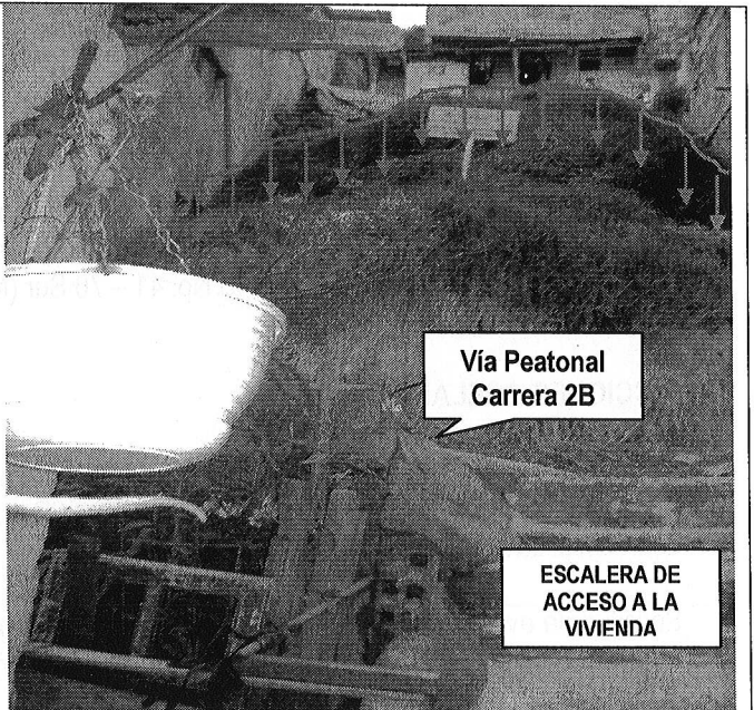
Fotografía 7 y 8. Se observa el predio de la Carrera 2B No. 41-76 Sur, el cual esta construido en mampostería simple y que se encuentra emplazado por debajo del nivel de la rasante de la vía, se evidencia la escalera de acceso al predio y el material que se desprendió del talud que podría sepultar la totalidad de la vivienda.
