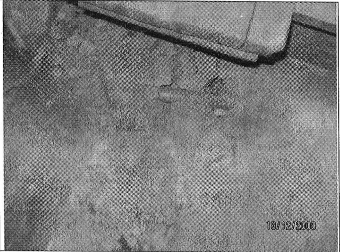
Foto 20. Fisura de 10 cm de ancho aproximadamente, presentada en pisos de la cocina, observándose la manguera de gas domiciliario del lote 4 de la manzana 19 (Observar Figura 1).
