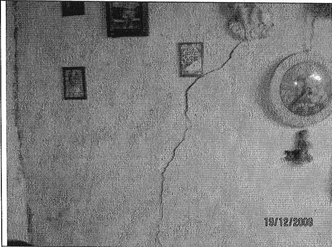
Foto 19 Fisura de 2 cm de ancho aproximadamente, presentada en muro del costado sur del lote 4 de la manzana 19 (Observar Figura 1).
