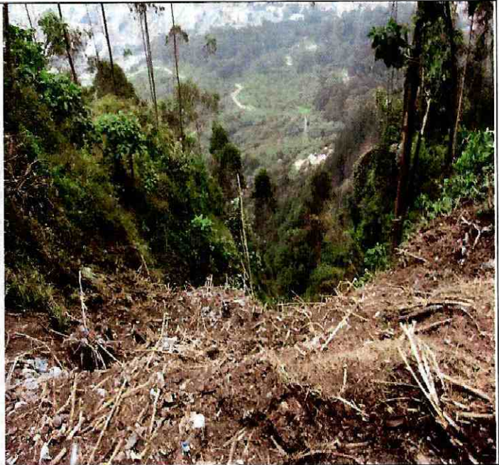
Foto 7 y 8. Parte Baja del talud natural y de relleno. Se observa la cicatriz dejada en el terreno por el material desprendido del talud, el cual se deslizo ladera abajo, arrasando a su paso la vegetación nativa.
