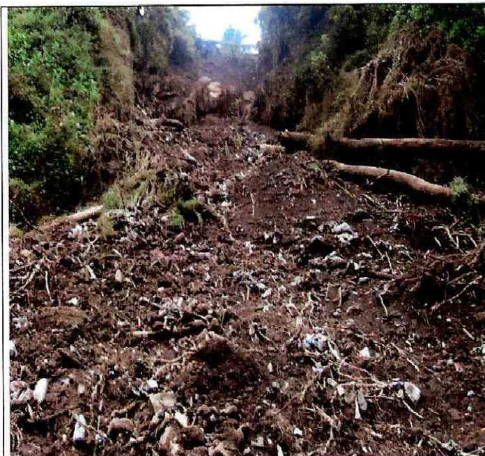
Foto 7 y 8. Parte Baja del talud natural y de relleno. Se observa la cicatriz dejada en el terreno por el material desprendido del talud, el cual se deslizo ladera abajo, arrasando a su paso la vegetación nativa.
