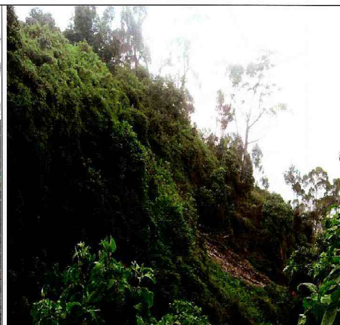
Foto 4. Vista general de la ladera natural afectada por el proceso de remoción en masa.
