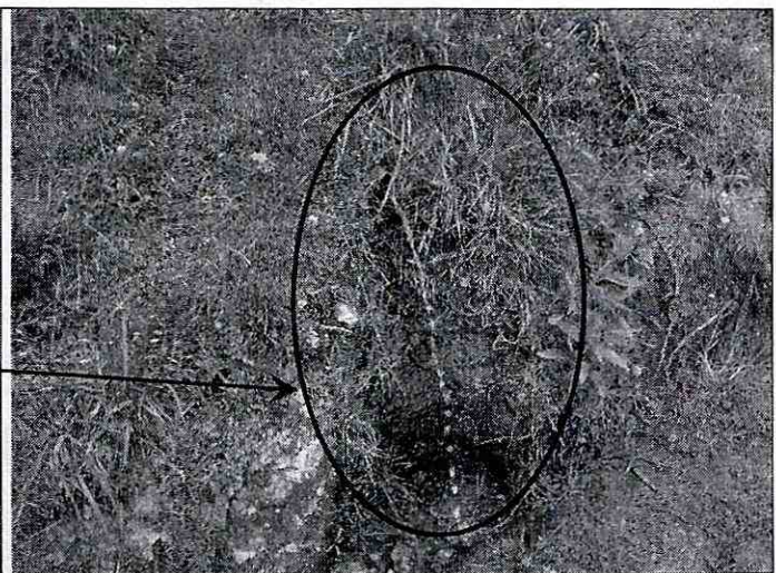
Foto 8. Vertimiento de aguas sobre la ladera natural. Sobre la ladera es común encontrar múltiples vertimientos de aguas, cuyo origen y estado (agua potable o servida), no es posible establecer con base en la inspección visual.
