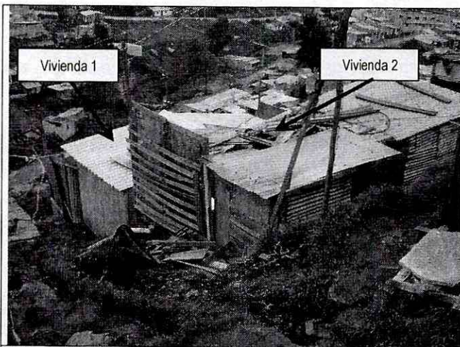
Foto 1. Vista general de ladera natural y distribución espacial de las viviendas evaluadas.
