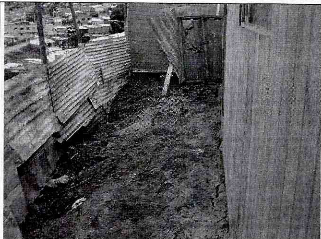
Foto 3. Relleno ubicado al costado oriental de la vivienda 1.
