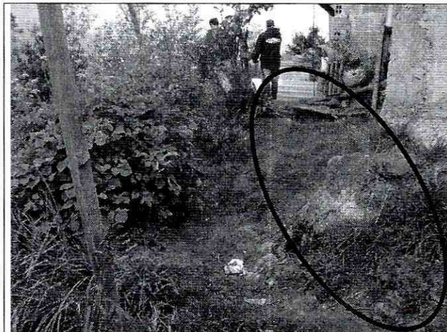
Foto 3 y 4. Vista general del escarpe principal del proceso de remoción en masa identificado. Se observa la cercanía del escarpe principal con la vivienda evaluada, lo que implica pérdida de confinamiento del terreno de cimentación de la misma.
