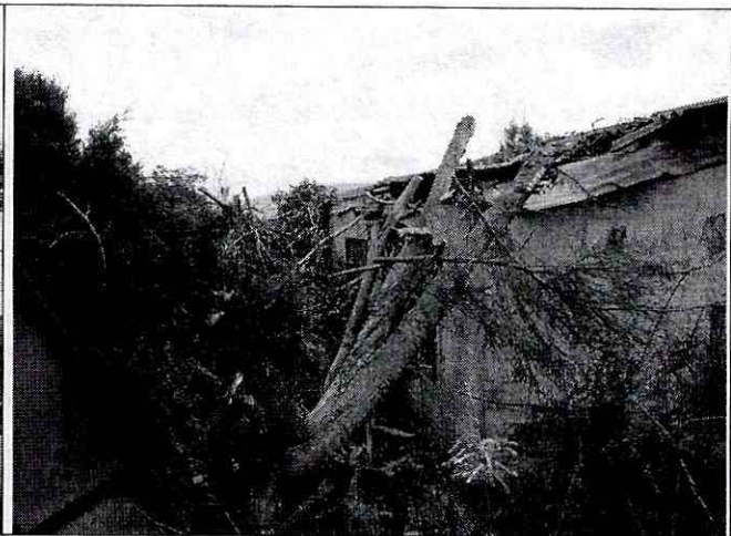
Foto 2. Costado Occidental de la vivienda, afectado por la caída del árbol.
