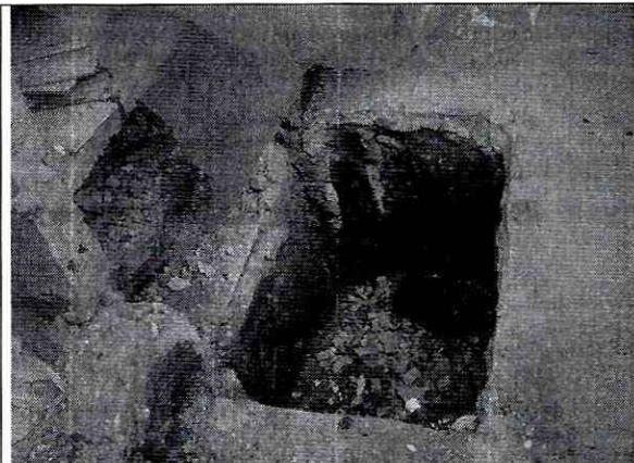
Foto 3. Excavación en el primer nivel de la vivienda evaluada, posiblemente realizada para la construcción de una (1) zapata destinada al reforzamiento de la vivienda en mención.
