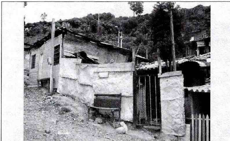
Fotografía 6. Viviendas localizadas en el Lote 11 (izquierda) y en el Lote 10 (derecha), de la Manzana 21.
