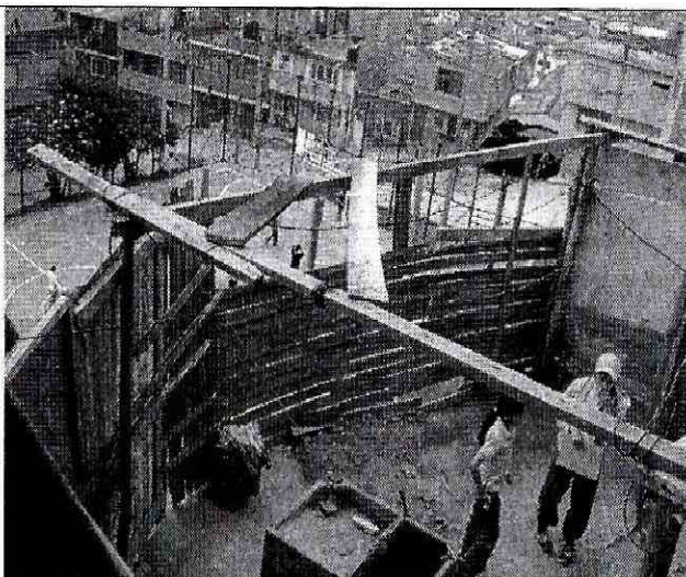
Foto 2. Patio de ropas y ubicación de la zona de lavado perteneciente a la vivienda de la Transversal 16F Bis # 49D - 31 Sur.
