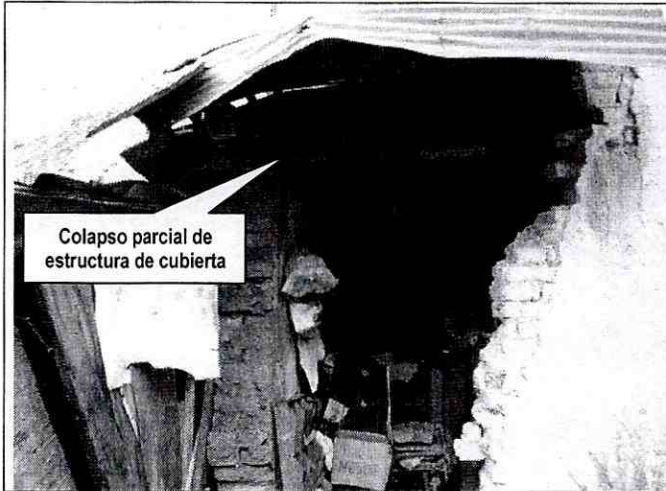
Foto 1. Aspecto frontal de la unidad habitacional de un nivel en adobe y material de recuperación, emplazada en la parte posterior del predio de la Calle 65 # 1 - 52, en el barrio Nueva Granada.
