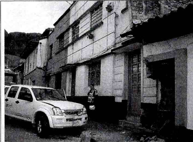
Fotografía 1. Vista del vehículo tipo pick-up de placas UPO-917 y del sector nororiental de la vivienda de la Calle 13 No. 1-57 afectado por el accidente del vehículo.
