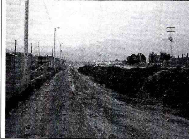
Fotografía 5. Vista del jarillón, colocado sobre la Diagonal 54 Sur, y construido a partir de material retirado del cauce de la quebrada (materia orgánica, limos y basuras principalmente); con el fin de evitar nuevos desbordamientos del cauce en este sector en el que falta la construcción de 3 módulos de la canalización en concreto.
