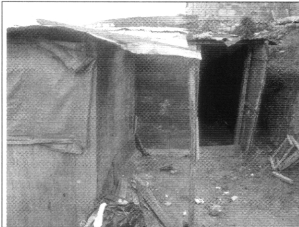
Fotografía No. 1. Fachada de la vivienda con nomenclatura Carrera 74B # 76 - 27 Sur
