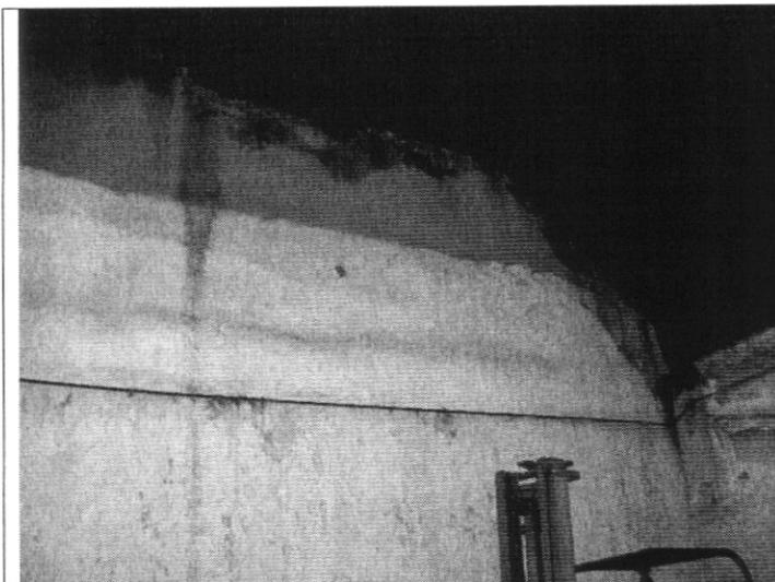
Fotografía 1. Vista de la parte superior muro perimetral en mampostería simple y bahareque del predio de la Carrera 12 No. 19-37.
