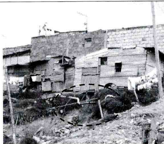
Fotografía 2. Se observa la retrogresión del proceso de remoción y la pérdida de suelo de cimentación en el predio del lote 15 de la Manzana K, donde habita la señora Luz Valderrama y su familia.
