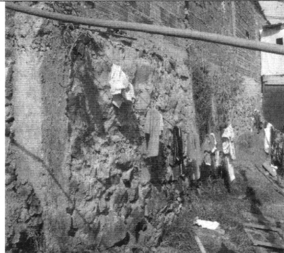
Fotografía No. 6. Muro de contención del talud sobre el cual se emplaza la vivienda con nomenclatura Calle 87 A # 47 B - 62 Sur
