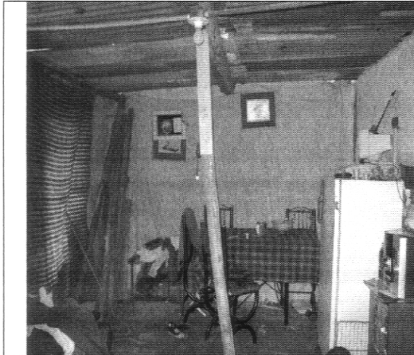
Fotografía No. 5. Reforzamiento provisional de la cubierta de la vivienda con nomenclatura Calle 87 A # 47 B - 62 Sur
