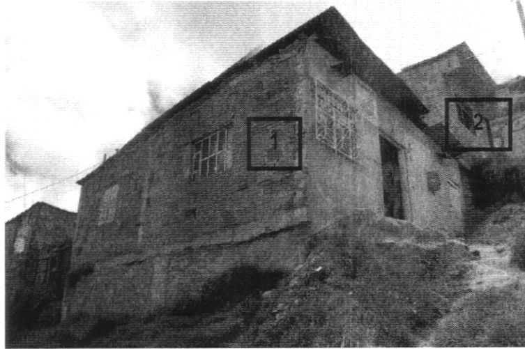
Fotografía 1. Vista de las viviendas desde la parte baja de la ladera. Los números 1 y 2 corresponden a las nomenclaturas Calle 81D Sur No. 19-13 y Calle 81D Sur No. 19-21 respectivamente
