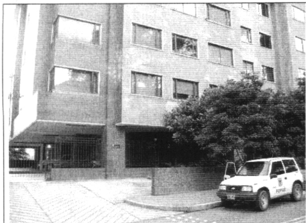
Foto 1. Fachada principal del Edificio Altos Horizontes, donde no se observaron daños o patologías estructurales que comprometan su estabilidad y/o habitabilidad en el largo plazo ante cargas normales de servicio.
