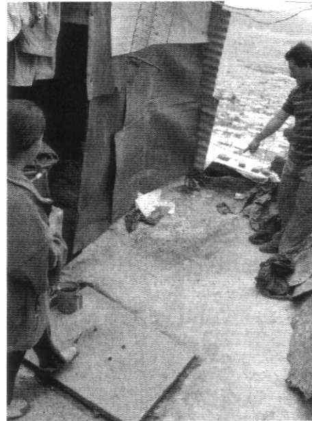
Fotografía 3. Sector de la vivienda correspondiente al baño y su zona aledaña, afectada por la pérdida de la superficie de cimentación
