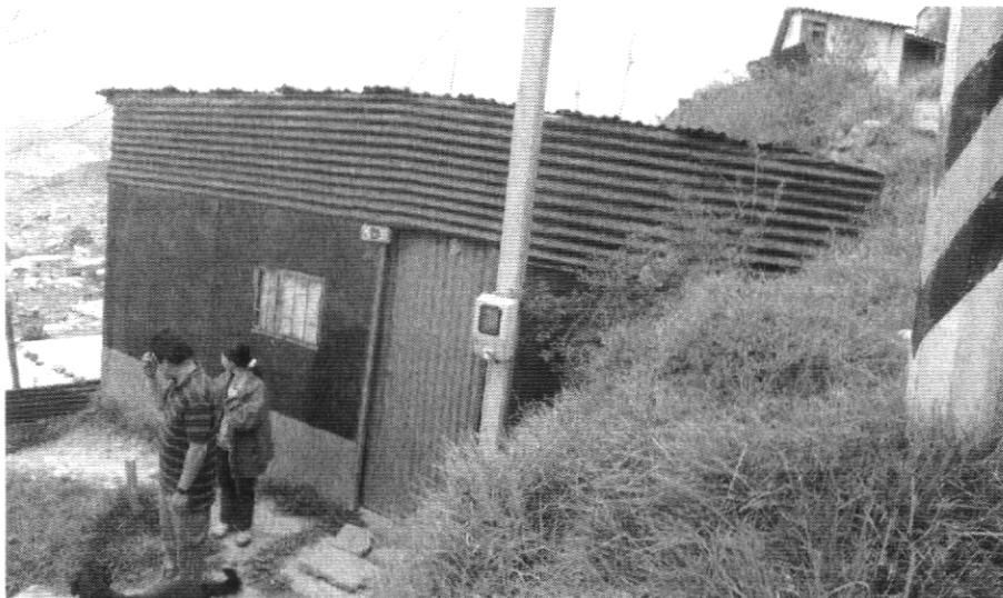
Fotografía 4. Vista de la vivienda desde la parte alta de la ladera. Nótase que en esta zona no se observa afectación en su integridad estructural
