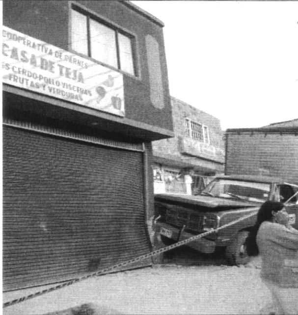
Fotografía 1. Se observa el sitio de impacto del camión de placas EWH-757 con la vivienda ubicada en la Carrera 17A # 74B - 16 Sur, donde habita la señora Stella Olarte y su familia.
