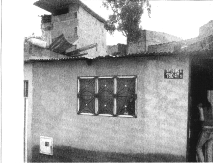
Foto 1. Fachada de la vivienda localizada en la Transversal 18 Bis A # 78C - 47 Sur correspondiente a una vivienda de un nivel en mampostería simple con cubierta de asbesto cemento.
