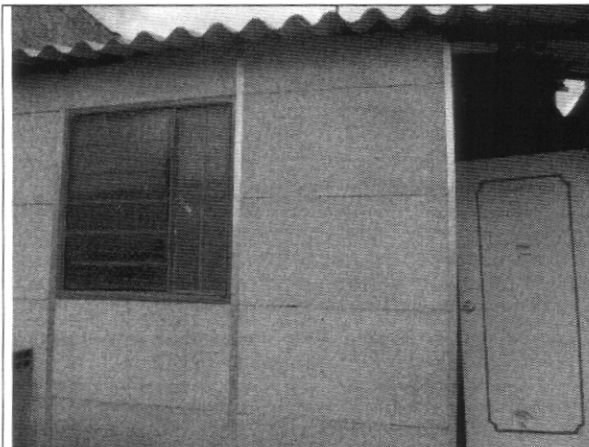
Fotografía No. 1. Fachada de la vivienda localizada en la Manz 74 Lote 27
