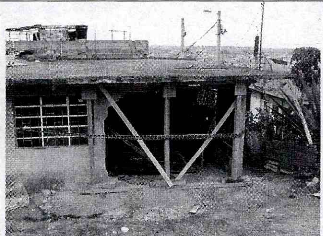
Fotografía 4. Aspecto final del apuntalamiento realizado por la Fuerza de Tarea en el costado sur-oriental de la vivienda de la Carrera 18V No. 64A-13
