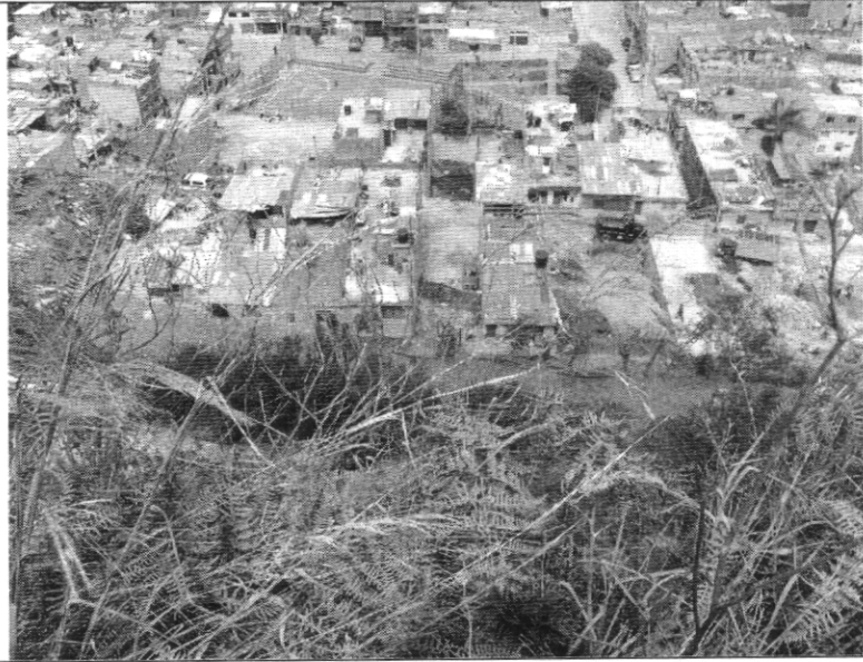
Fotografía 4. Vista de las viviendas del desarrollo San Juan Bosco II Sector adyacentes a la zona verde 2 (ZNV2) localizadas hacia la parte baja. Dichas viviendas podrían resultar afectadas por los procesos de inestabilidad del macizo rocoso.
