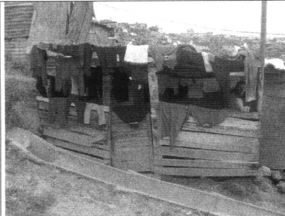
Fotografía No. 1. Fachada de la vivienda con nomenclatura Carrera 74G # 75B-15.
