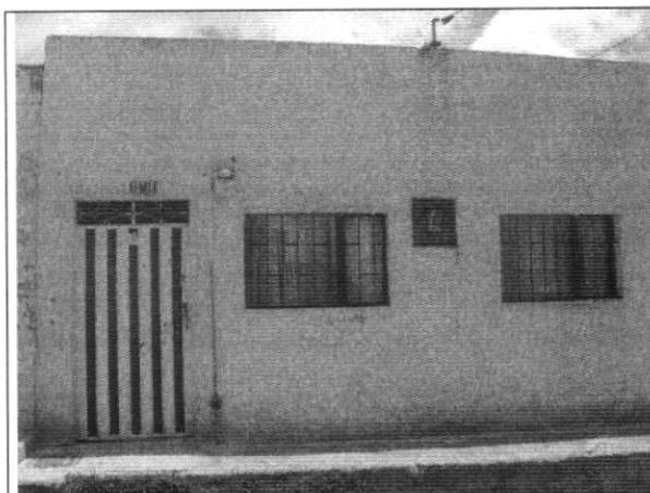
Fotografía No. 1. Fachada de la vivienda con nomenclatura Calle 71N Sur # 19D – 18.
