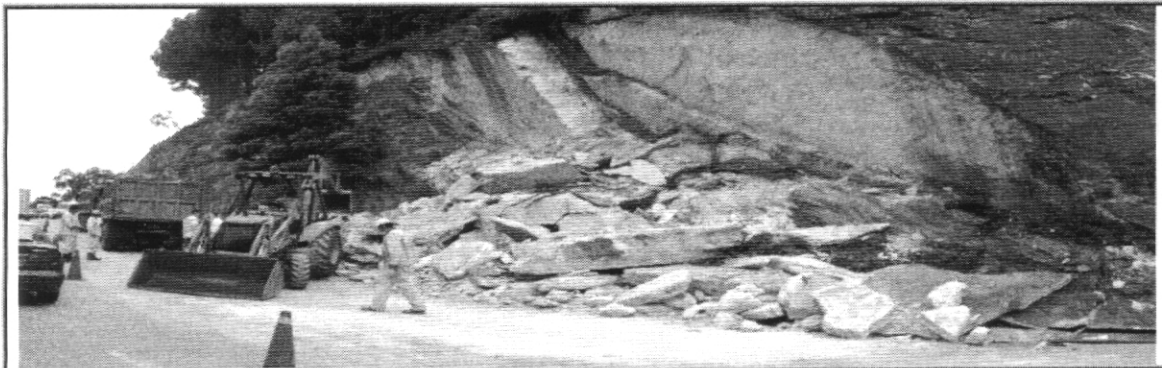
Foto 4. Trabajos de retiro de material presente en la calzada oriental de la vía.
