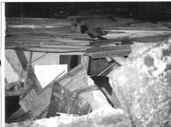
Fotografía 1. Vista de la cubierta de la vivienda ubicada en la Carrera 16 # 33 - 18 Sur (Nueva).
