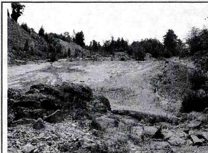
Fotografía 7. Vista de la antigua Cantera Servitá. No se aprecian evidencias de procesos de inestabilidad; tampoco se observan obras de control de drenaje.
