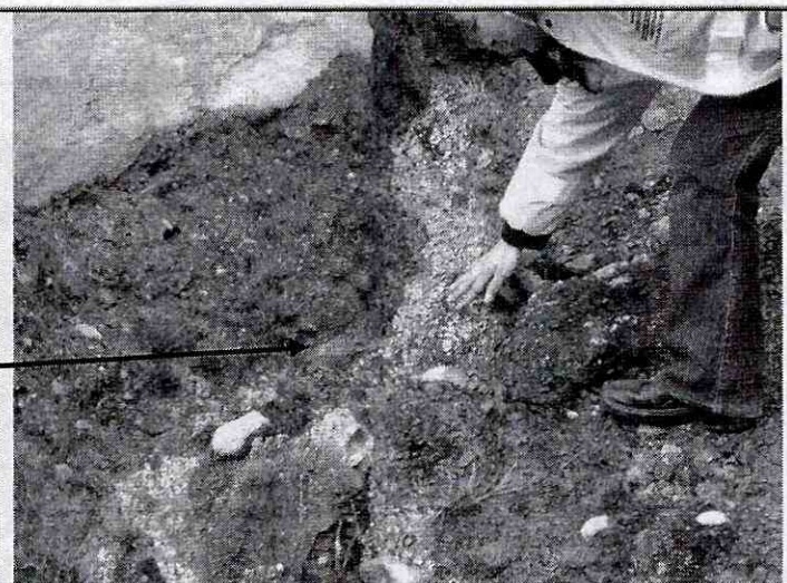
Fotografía 2. Se aprecia el agua que se infiltra en el terreno, cargada de óxidos de hierro.
