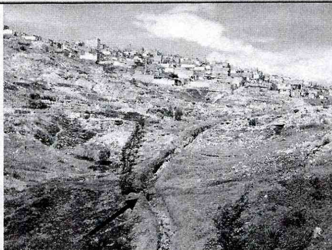
Fotografía 1. Panorámica de los barrios Cerro del Diamante y Espino I sector afectado por el deslizamiento. Nótese el cauce de la quebrada Santa Rita.
