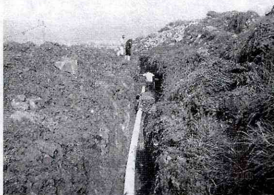
Fotografía 18. Vista de la instalación de la tubería Novafort en la excavación
