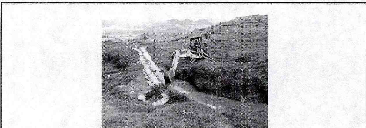
Fotografía 10. Intervención de la maquinaria de la Alcaldía Local de Ciudad Bolívar para la rectificación y ampliación del canal de desviación del cauce de la quebrada Santa Rita
