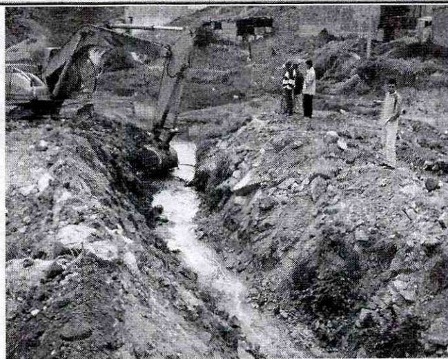
Fotografía 3. Adecuación y limpieza del cauce de la quebrada Santa Rita.
