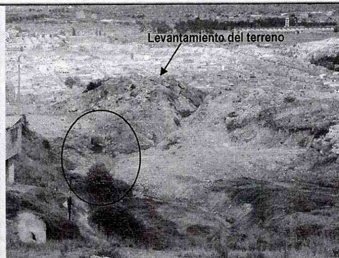
Fotografía 4. Nótese hacia el costado norte el levantamiento de San Rafael y construcción de la obra de drenaje para la quebrada Santa Rita.
