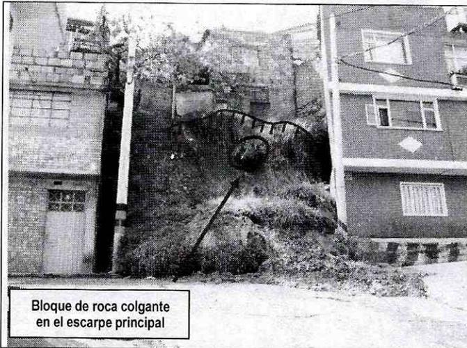
**Fotografía 1.** Evento del 1 de noviembre de 2006 – Predio con nomenclatura Diagonal 35 Sur No. 17 – 51, en el que en la parte posterior se presentó la falla del talud de corte generando desprendimientos de suelo.
